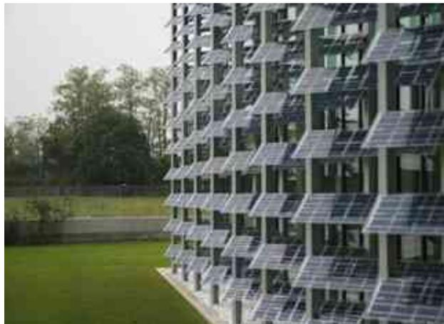
Frangisole sovrapposti alle facciate - Il frangisole fotovoltaico ha la duplice funzione di regolare luminosità e temperatura all'interno degli ambienti e di trasformare direttamente l'energia solare in energia elettrica.
