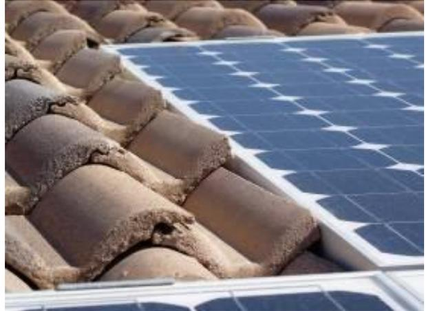
Esempi di coperture a falde inclinate con moduli fotovoltaici installati in modo complanare alla superficie del tetto con sostituzione della medesima superficie.
