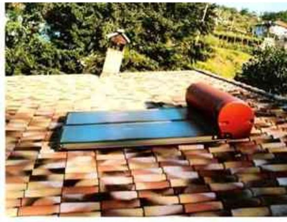
Pannelli solari del tipo sottovuoto installati su supporto inclinato.
