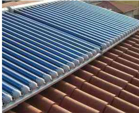
Pannelli solari rispettivamente piano e a tubi sottovuoto installati in modo complanare alla copertura. Questo tipo di installazione presuppone un sistema a circolazione forzata oppure un sistema a circolazione naturale con serbatoio di accumulo posizionato nel sottotetto ad una quota più alta rispetto al pannello stesso.
