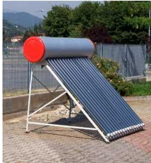
Installazioni a terra su supporto inclinato rispettivamente di un collettore piano e di un pannello a tubi sottovuoto, entrambi a circolazione naturale.
