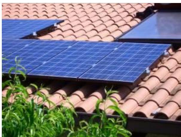
Esempi di coperture a falde inclinate con moduli fotovoltaici installati in modo complanare alla superficie del tetto senza sostituzione della medesima superficie.
